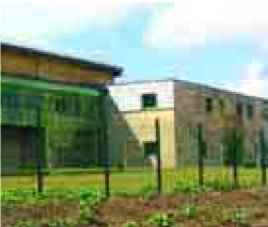
Centre de tri des déchets de Fumay (08) Bardage Aulne non traité - sans entretien
